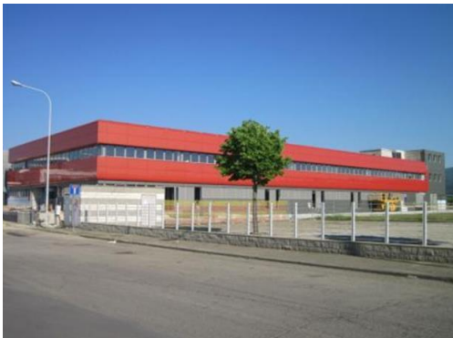
Figura 5: Immagine esterna del Datacenter
