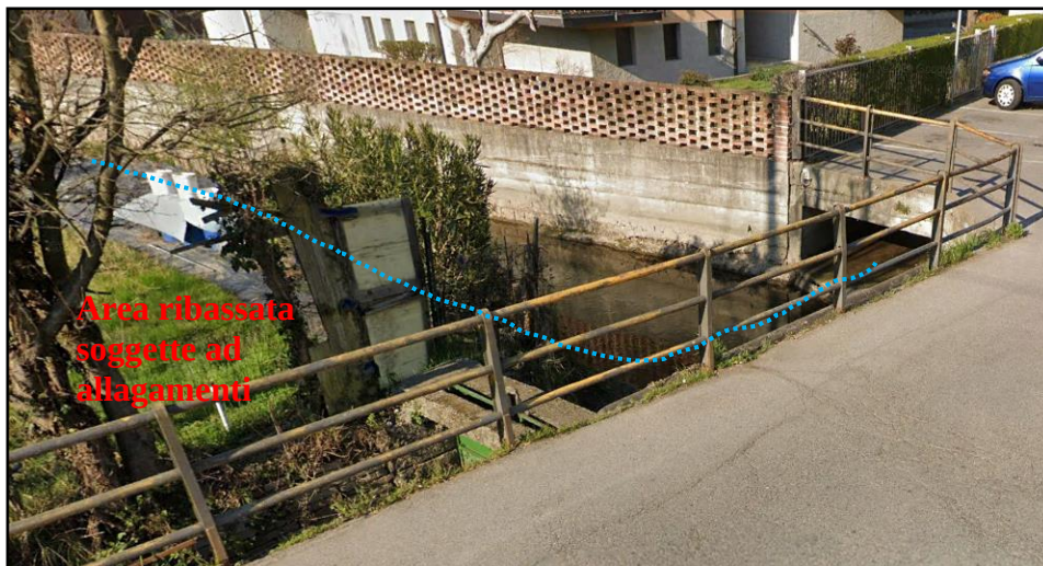
Figura 8 – Intubamento scaricatore fiume Tormo presso SP81.
