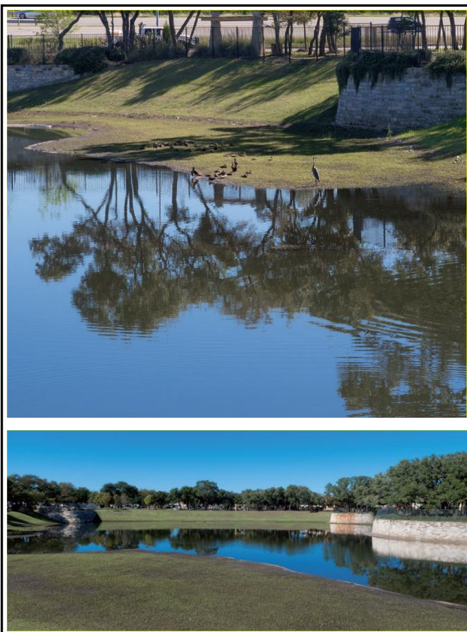
Figura 27 – Esempi di bacini di detenzione per lo stoccaggio delle acque di pioggia a seguito di eventi meteorici di forte intensità.
