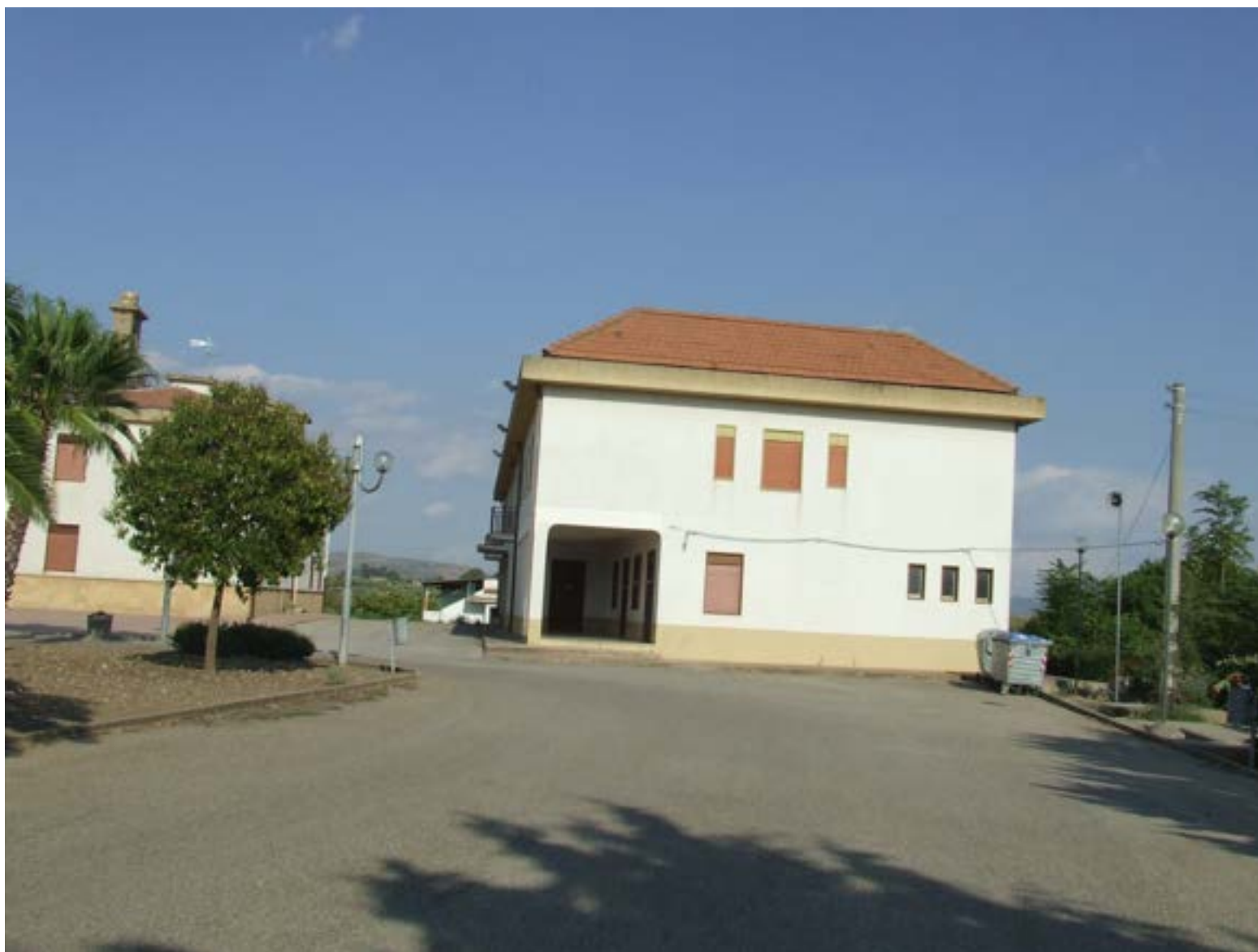
Figura 20 Casa del Pellegrino (SE10)
