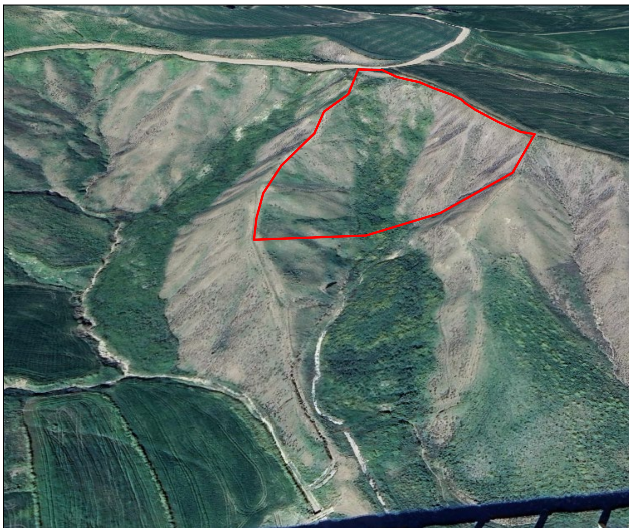
FIG. 3 – ORTOFOTO SITO DELLA EX DISCARICA (ID 499 )
