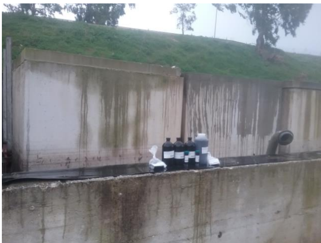
Figura 6 – Serbatoi raccolta percolato vasca F e Ampliamento
